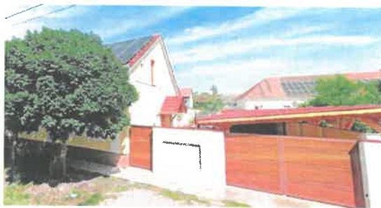
Makó, Mikes Kelemen utca 25. (hrsz.: 4720)
