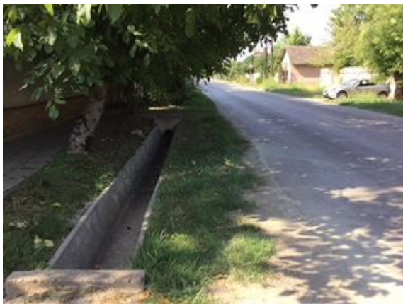
Csapadékvízvezető az Almási u. páros oldalán
