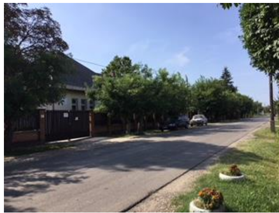
Meglévő – bontandó iskolaépület
