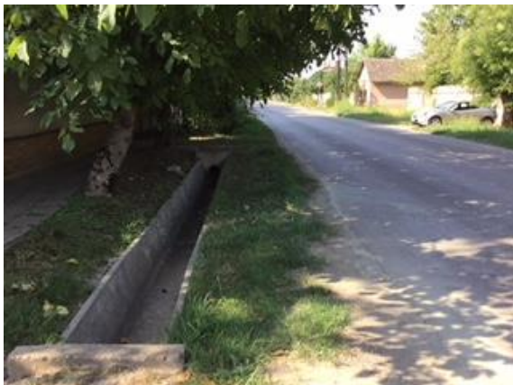
Csapadékvízvezető az Almási u. páros oldalán
