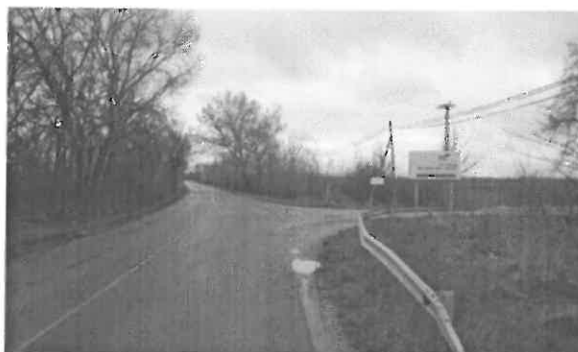
4414 j. ök. út 3+300 km. sz. környezte
