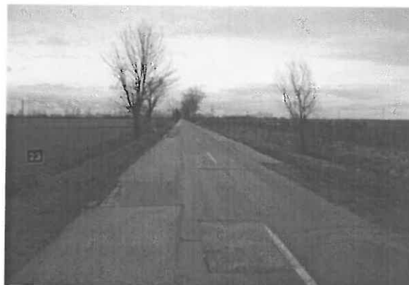
4414 j. ök. út 23+000 km. sz. környezte
