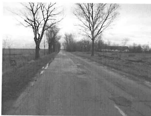
4414 j. ök. út 25+000 km. sz. környezte
