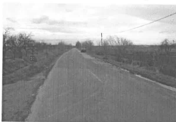
4414 j. ök. út 27+000 km. sz. környezte
