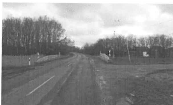
4414 j. ök. út 12+450 km. sz. környezte
