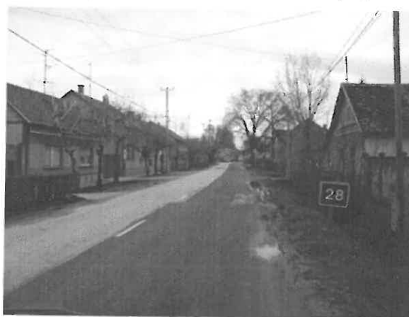
4414 j. ök. út 28+000 km. sz. környezte
