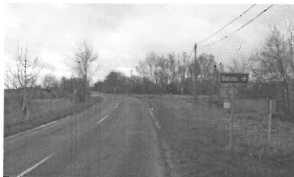
4414 j. ök. út 7+500 km. sz. környezte
