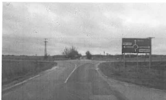
4414 j. ök. út 0+650 km. sz. környezte
