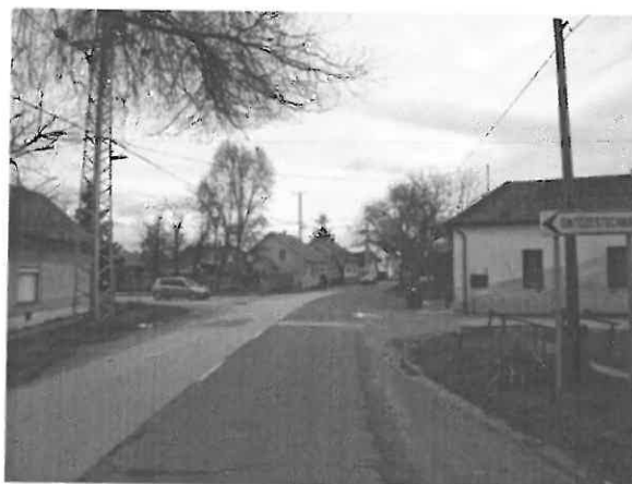
4414 j. ök. út 28+000 km. sz. környezte
