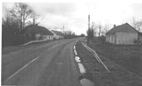
4414 j. ök. út 13+000 km. sz. környezte
