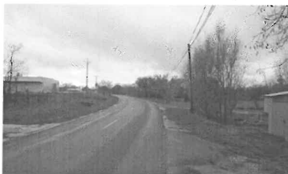
4414 j. ök. út 1+500 km. sz. környezte
