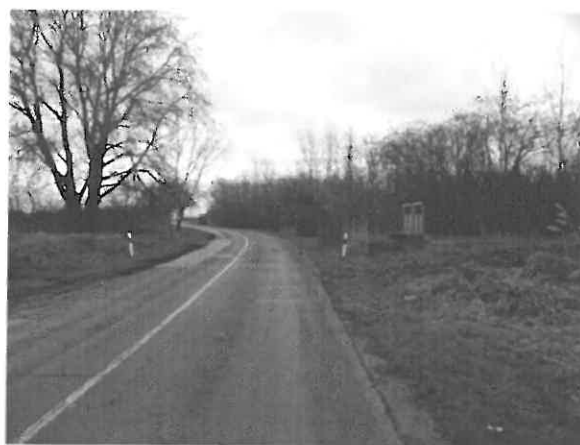
4414 j. ök. út 21+500 km. sz. környezte
