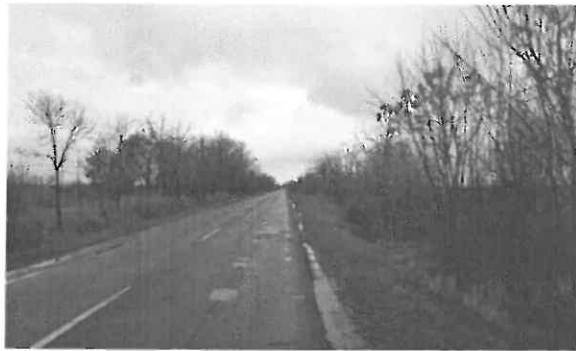
4414 j. ök. út 3+800 km. sz. környezte
