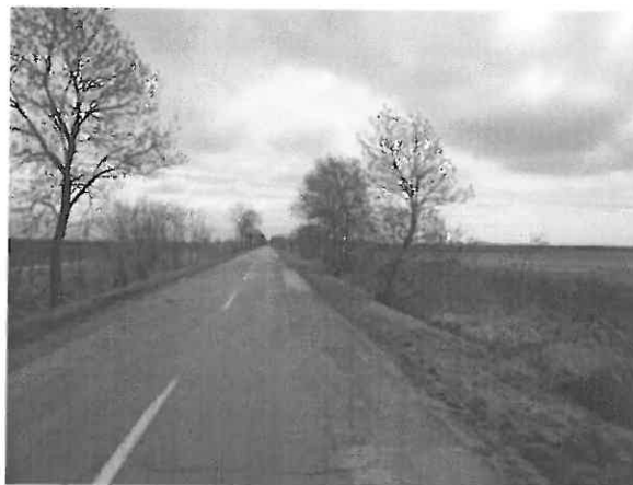
4414 j. ök. út 20+100 km. sz. környezte
