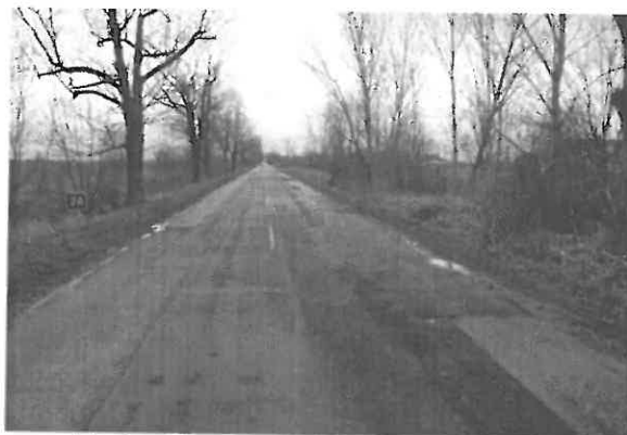
4414 j. ök. út 24+000 km. sz. környezte
