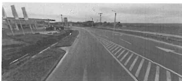
4414 j. ök. út 16+300 km. sz. környezte
