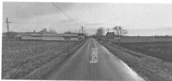
4414 j. ök. út 27+400 km. sz. környezte
