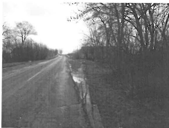
4414 j. ök. út 21+600 km. sz. környezte
