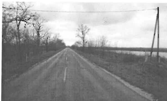
4414 j. ök. út 14+300 km. sz. környezte
