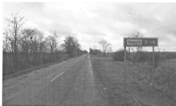
4414 j. ök. út 8+700 km. sz. környezte
