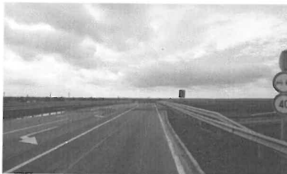
4414 j. ök. út 16+000 km. sz. környezte
