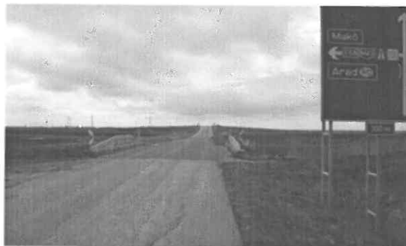
4414 j. ök. út 15+500 km. sz. környezte
