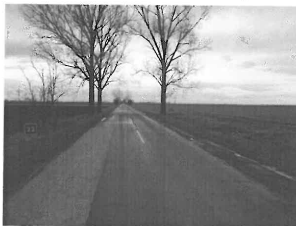
4414 j. ök. út 22+000 km. sz. környezte
