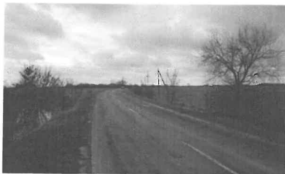
4414 j. ök. út 10+000 km. sz. környezte
