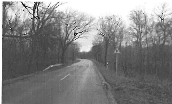
4414 j. ök. út 4+800 km. sz. környezte
