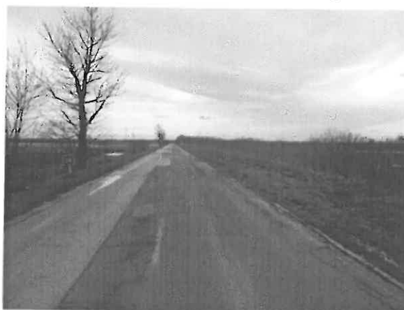
4414 j. ök. út 26+000 km. sz. környezte
